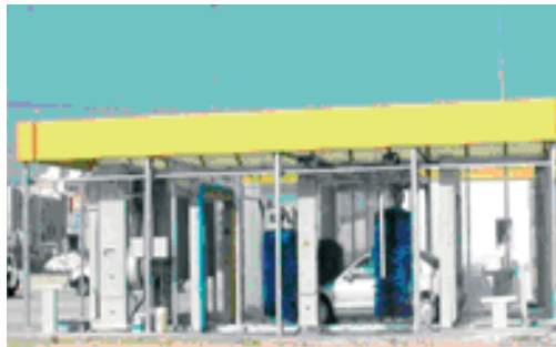
Túnel de lavado
